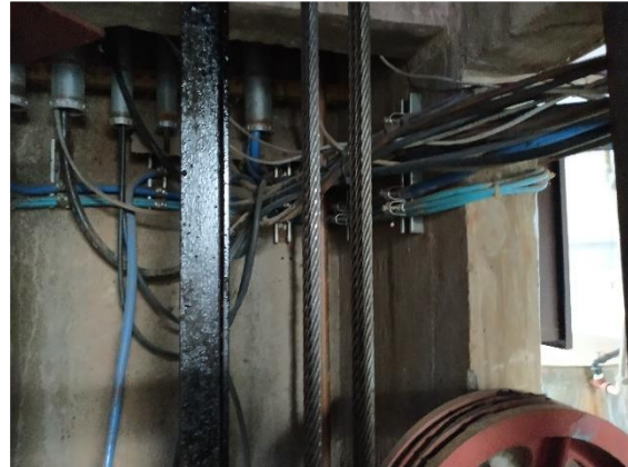
Bajorecorrido, poleas cables de tracción, resorte, etc.
