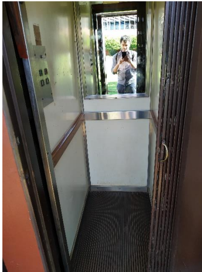
Cabina y contacto puertas. Contactos con mal funcionamiento. Cabina con oxidación en estructura y bajo plataforma
