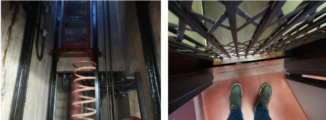
Pasadizo y acceso cabina. Puerta de cabina no aprobadas por normativa
