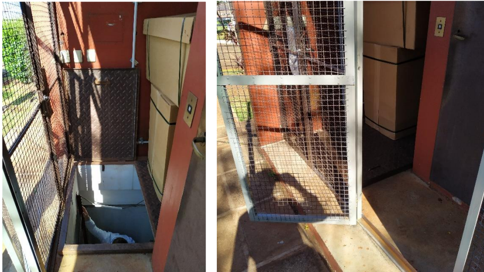
Acceso Sala de máquinas
