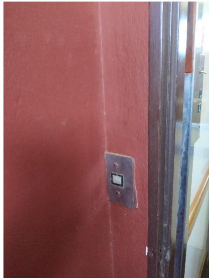
Botonera palier y contacto puerta - Cambio y readequación a normativa.
