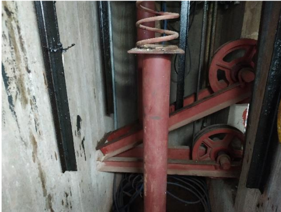
Bajorecorrido, poleas cables de tracción, resorte, etc.
