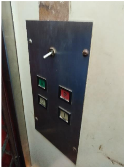
Botonera cabina y puerta acceso cabina. Puertas cabina antirreglamentaria. Las mismas se deben reemplazar por puertas de tablilla ciegas.
