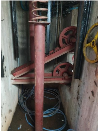
Polea de tracción y polea de desvío. La misma se encuentra en malas condiciones.
