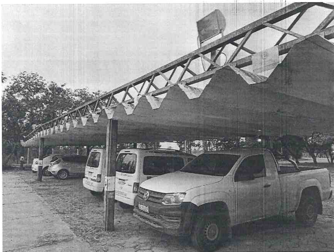
(Imagen A) Estructura existente de estacionamiento exterior total a desmontar/demoler
