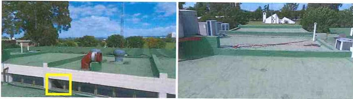
*Figura 0. Cubierta ACC Plana con vigas invertidas.*
