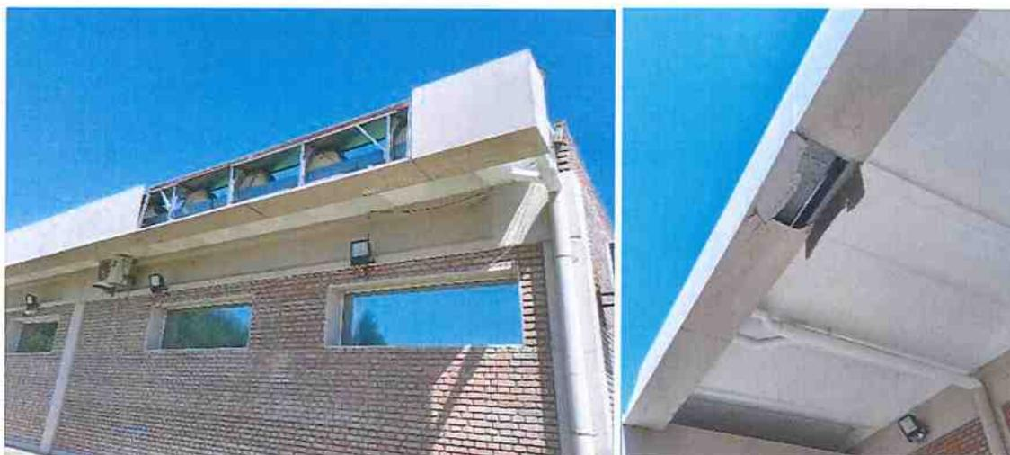
*Placas de revestimiento de canaletas de fibrocemento.*
