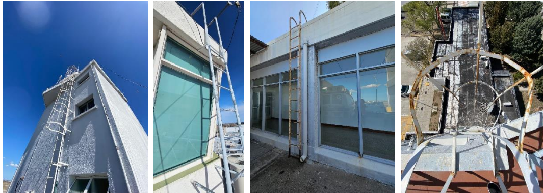
Imágenes ilustrativas de las escaleras.
